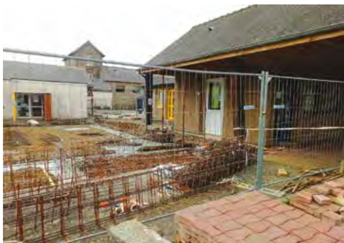
9 février 2022 - Fondations de la future salle de motricité qui reliera les deux bâtiments : l'école maternelle et l'accueil périscolaire.
