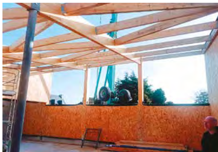
22 mars 2022 - Montage de la structure bois avec ses caissons de paille isolants de la salle de motricité sous l'œil attentif du maître d'œuvre : vue sur les futures baies vitrées.
